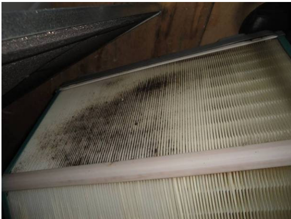
Figuur 17 (links): Voorbeeld van vervuiling van het WTW-blok.
