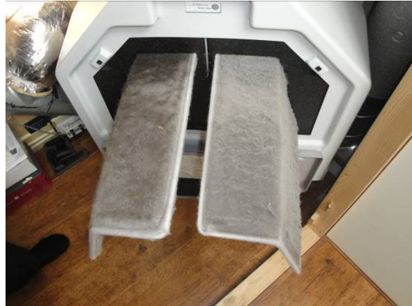
Figuur 16 (rechts): Voorbeeld van gebruikte filters in een ventilatie-unit (balansventilatie). Er is een duidelijk verschil tussen de mate van vervuiling bij de toevoer (filter links) en de afvoer (filter rechts).
