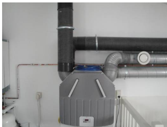
Figuur 9 (links): Het buitenluchtaanzuigkanaal is voorzien van veel bochten, waardoor de druk in de kanalen toeneemt. Hierdoor vermindert de ventilatiecapaciteit en neemt het installatiegeluidniveau toe.
