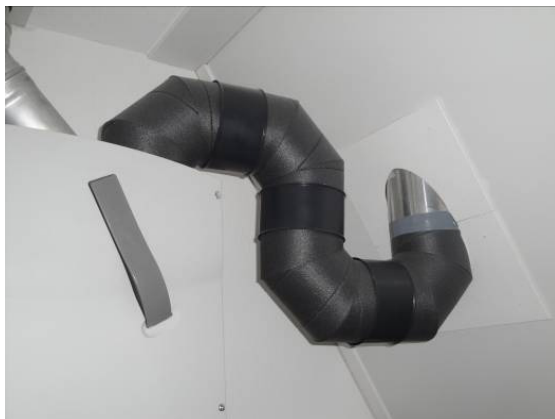
Figuur 9 (links): Het buitenluchtaanzuigkanaal is voorzien van veel bochten, waardoor de druk in de kanalen toeneemt. Hierdoor vermindert de ventilatiecapaciteit en neemt het installatiegeluidniveau toe.
