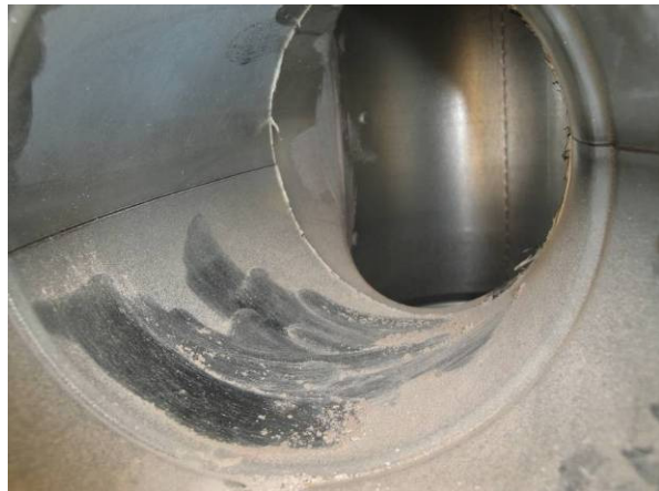
Figuur 17 (links): Voorbeeld van vervuiling van het WTW-blok.
