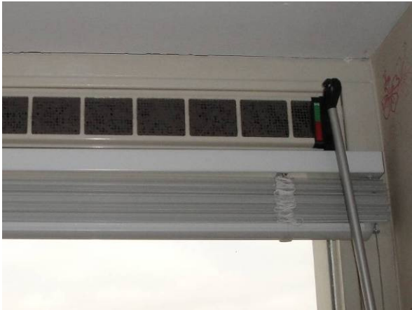
Figuur 15 (links): Voorbeeld van een vervuild gevelrooster.
