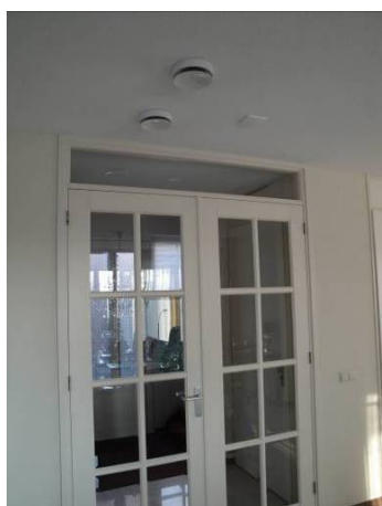
Figuur 22 (links): Voorbeeld van 'De onderlinge afstand tussen inblaasventielen is minder dan 1 m' en 'Inblaasventielen zijn op een afstand < 30 cm van plafond of wand aangebracht en niet voorzien van een schone sector'. Hierdoor wordt het risico op tocht vergroot. Figuur 23 (rechts): Voorbeeld van een inblaasventiel voorzien van een zgn. schone sector. Bij deze ventielen is de luchtstroom deels geblokkeerd (in dit geval door een witte kunststof klep aan de rechter kant), waardoor geen lucht wordt ingeblazen in de richting van bijvoorbeeld wand of plafond.
