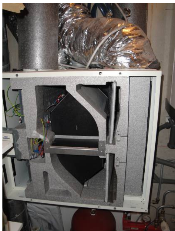
Figuur 21: Het inwendige van een ventilatie-unit met balansventilatie. Duidelijk zichtbaar zijn de zeshoekige warmtewisselaar met daarvoor de bypass (ruimte in de unit waardoor lucht langs de warmtewisselaar kan stromen).
